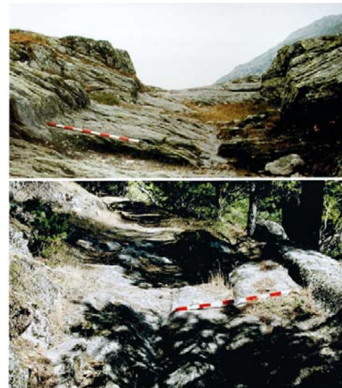
Figura 2. Entalles y rodadas sobre roca. Arriba: en la vía romana del Gran San Bernardo (foto Isaac Moreno) Abajo: en el Camino Viejo a Segovia.
