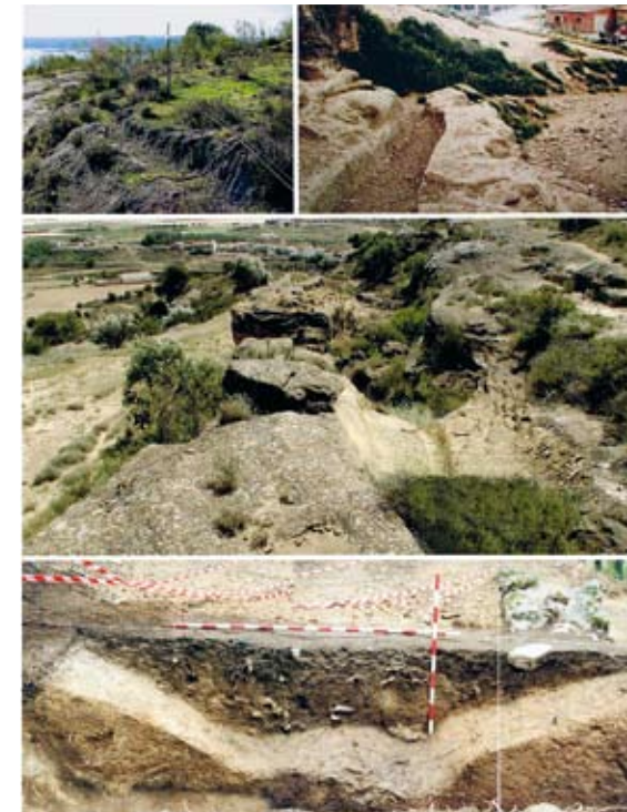
Figura 4. Cunetas de guarda en vías romanas. Arriba, a la izquierda: en la Vía de la Plata (foto Juan Gil). Arriba, a la derecha y en el centro: en la Vía de Italia in Hispania (foto Isaac Moreno). Abajo: en el Camino Viejo a Segovia.
